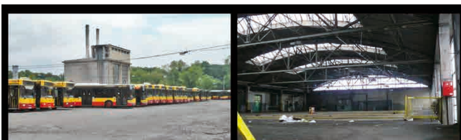
Na Redutowej ma powstać najnowocześniejsza zajezdnia w Polsce z miejscem dla około 300 autobusów, w tym 100 przegubowych i 100 elektrycznych.
